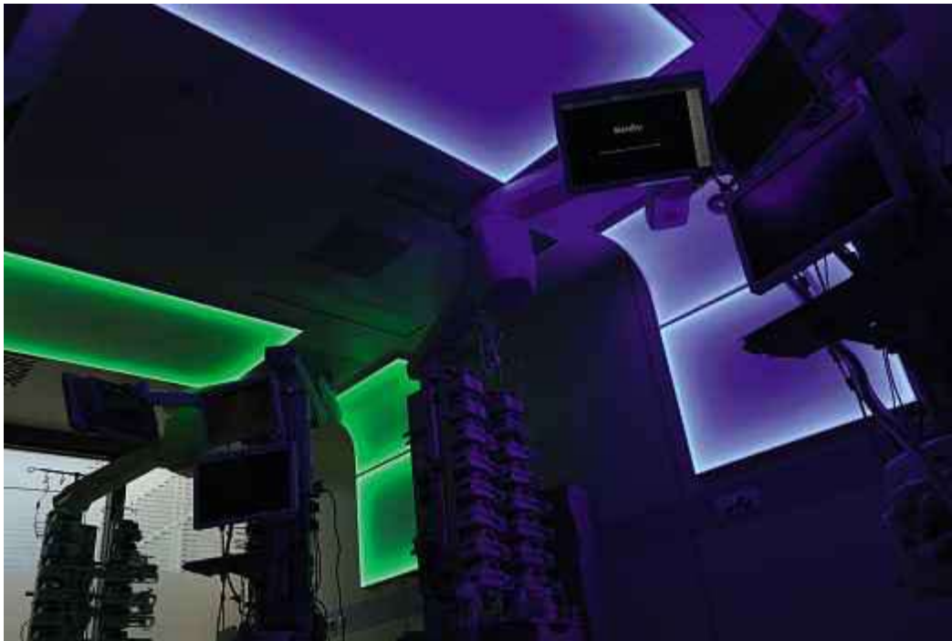
▲ Die manuelle Bedienung der Leuchten ist möglich und erfolgt über ein selbsterklärendes Wandpanel, das vom Klinikpersonal direkt bedient werden kann. Der Wechsel der zirkadian gesteuerten Beleuchtung erfolgt automatisch.
